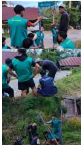
Gambar 11 Pemasangan petunjuk Jalan di Dusun Dulang dan Madandan
